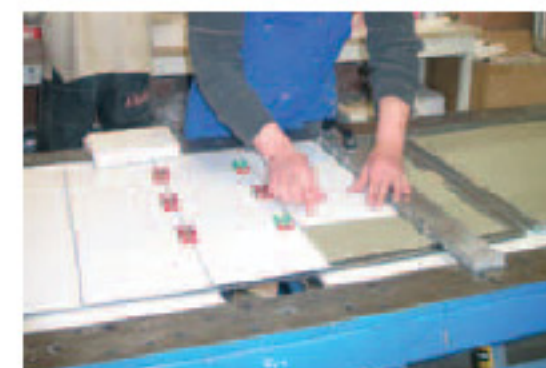
Fertigung der Badwand im Werk
